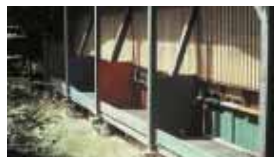
Nur einfach gebaute Bienenhäuser mit möglichst leicht zerlegbarer Holzkonstruktion auf nicht massiven Fundamenten sind zulässig. Zur Belichtung erhielt die Vorderseite Lichtwellplatten.
