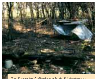
Das Bauen im Außenbereich als Privilegierung geht einher mit der Verpflichtung, das Landschaftsbild nicht zu stören. Dieser langjährig vor sich hingammelter Bienenstand mußte beseitigt werden.
